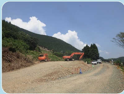
1号工事用道路盛土状況 □搬入路を作っています□
