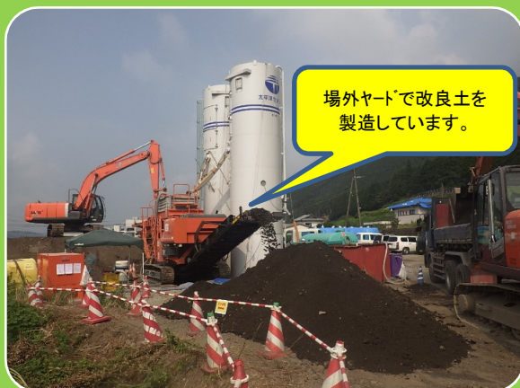
改良土製造状況
