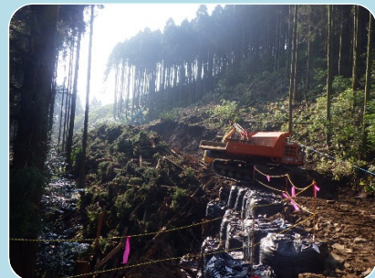
頭部1号工事用道路造成 □頭部から工事が進むように道を作っています□
