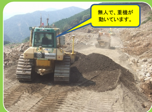
土留盛土工施工状況(上段)
