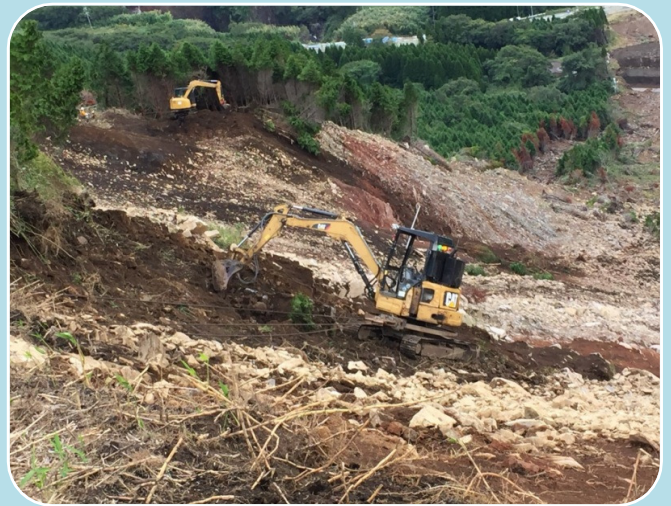
頭部排土工施工状況
