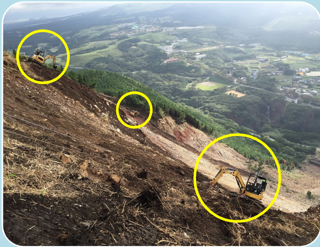
頭部排土工施工状況
