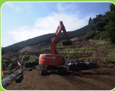
2号工事用道路進捗状況
