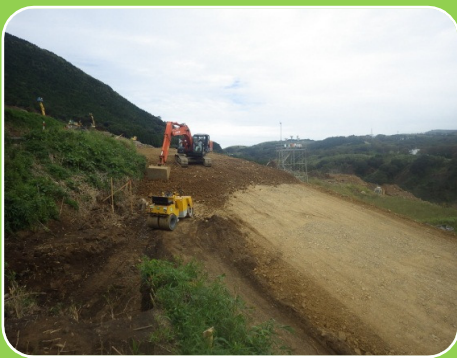
1号工事用道路進捗状況
