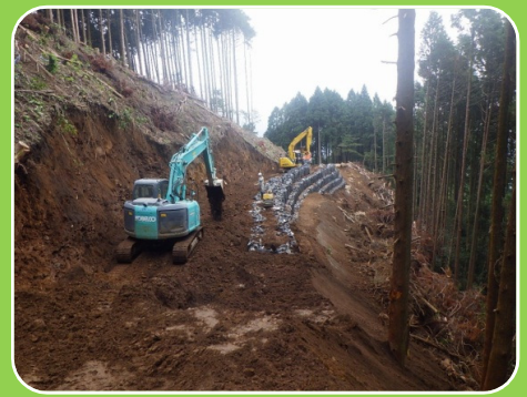
頭部工事用道路進捗状況
