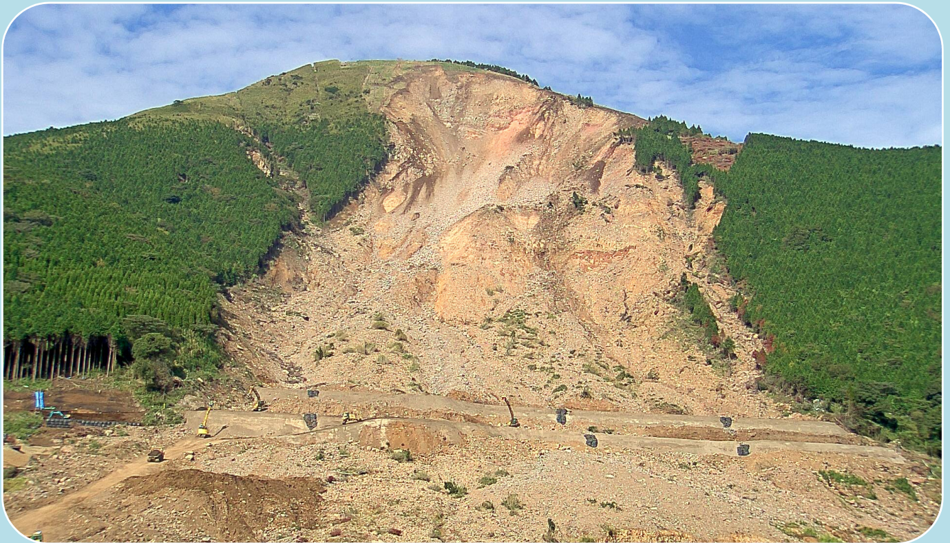
阿蘇大橋地区の斜面崩壊状況 (平成28年10月20日撮影)
