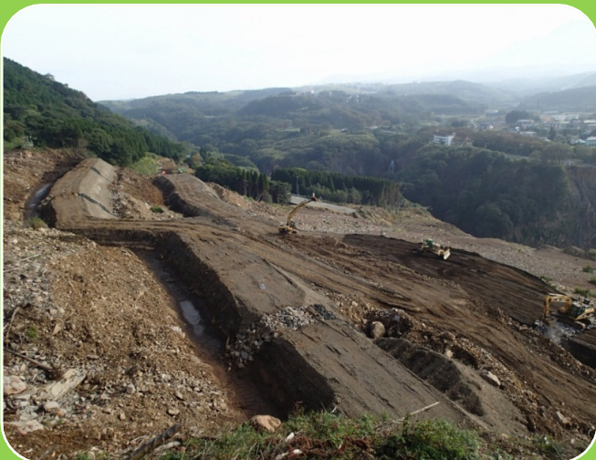
土留盛土工（熊本側より撮影）
