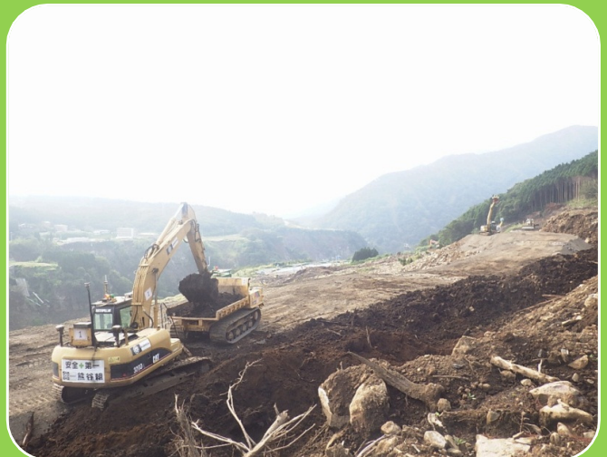
土留盛土工（大分側より撮影）
