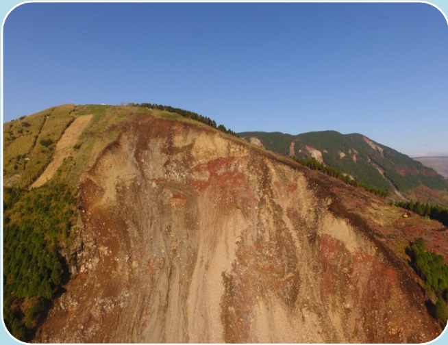
頭部排土工進捗状況
