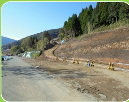
2号工事用道路進捗状況
