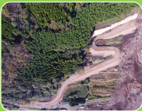
1号工事用道路進捗状況
