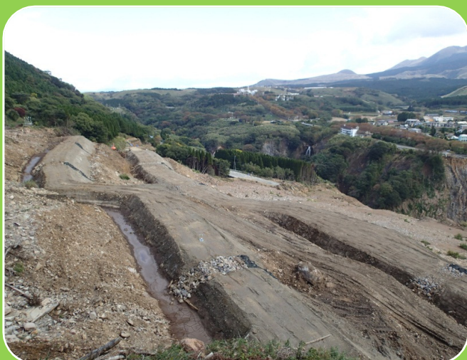
土留盛土工（熊本側より撮影）
