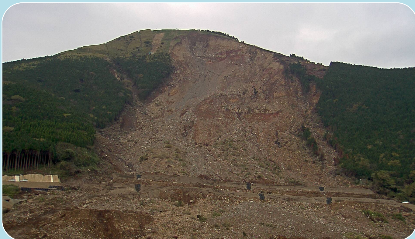
阿蘇大橋地区斜面崩壊対策の進捗状況 (平成28年11月30日撮影)
