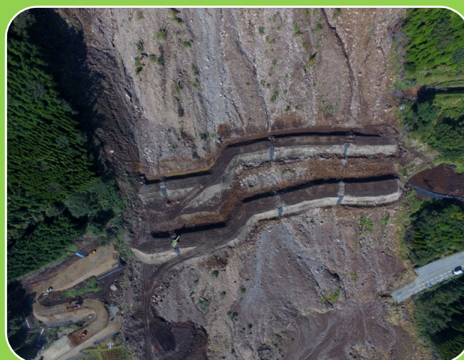
土留盛土工（ドローンによる撮影）
