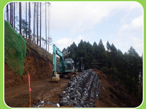
頭部工事用道路進捗状況
