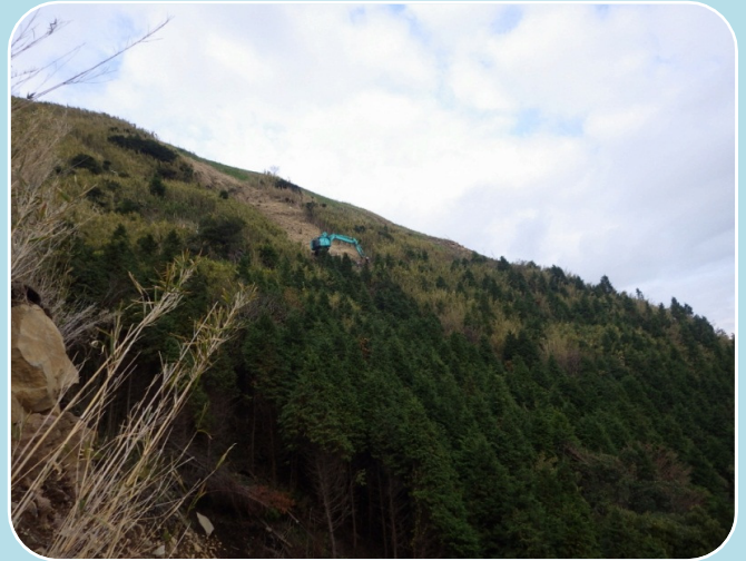
ガリー対策工施工状況
