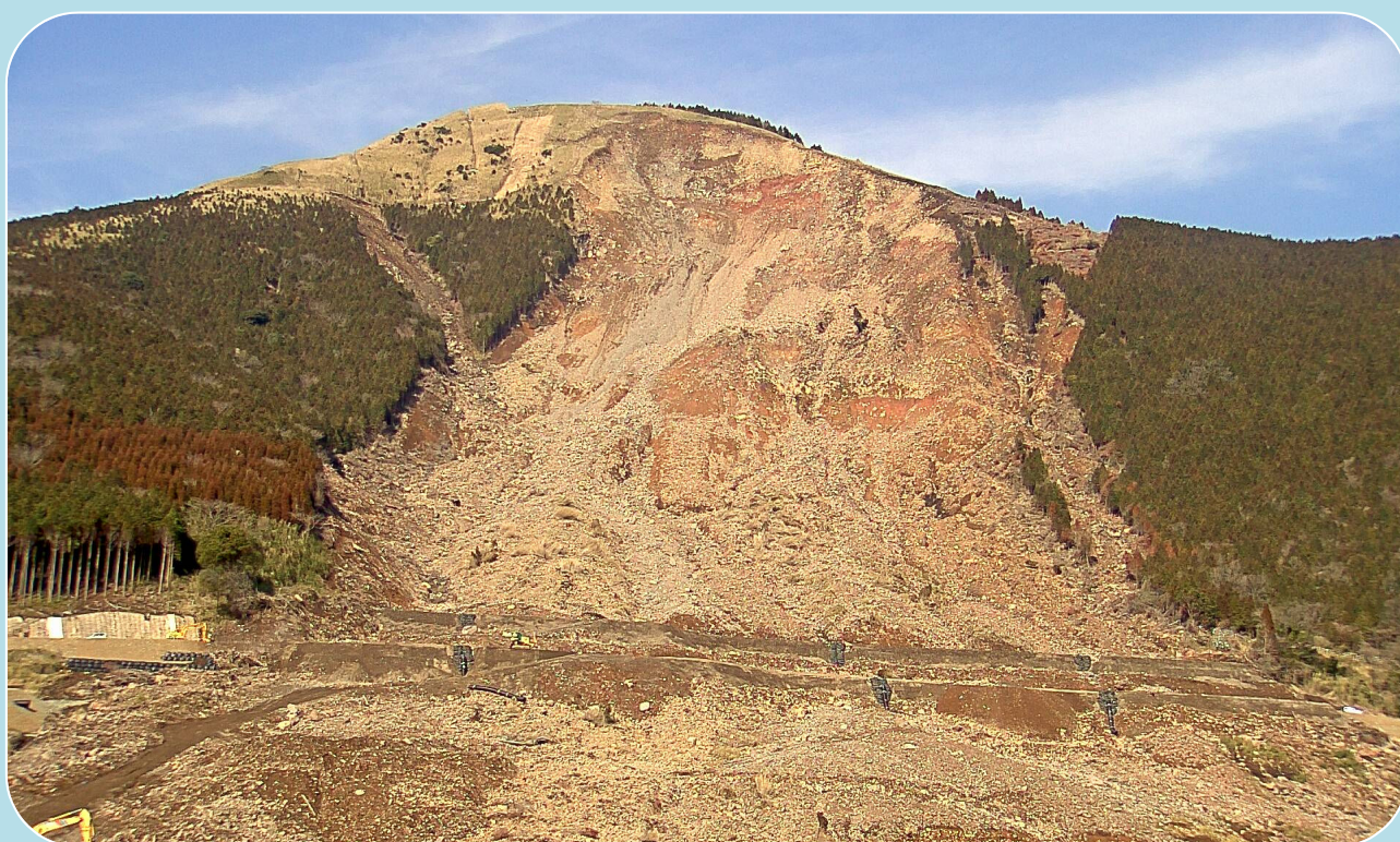
阿蘇大橋地区斜面崩壊対策の進捗状況 (平成29年2月21日撮影)
