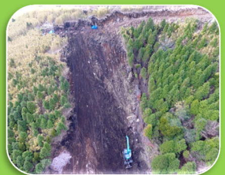
ガリー対策工施工状況
