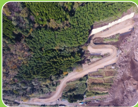
1号工事用道路ドローン撮影状況
