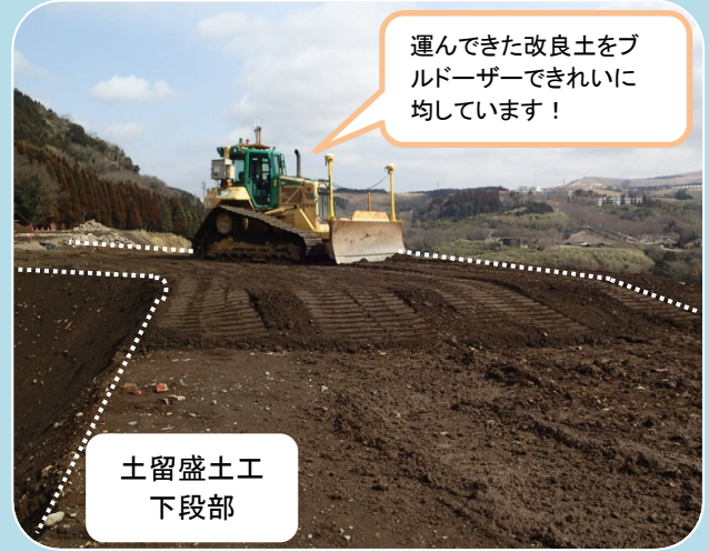
土留盛土工(下段部)施工状況
