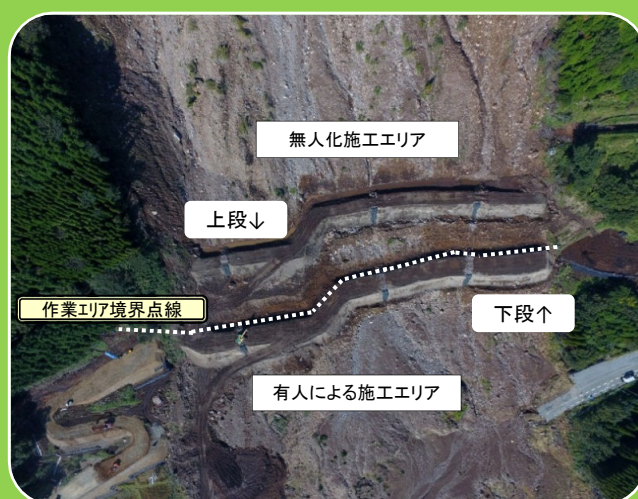
土留盛土工（ドローンによる撮影）
