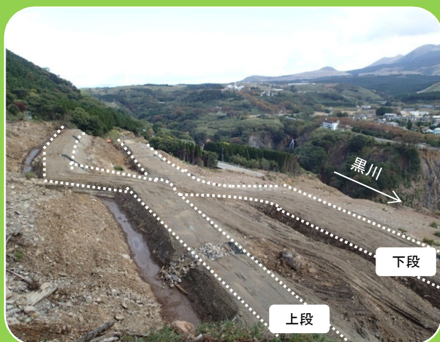
土留盛土工（熊本側より撮影）
