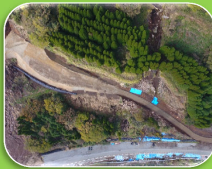
2号工事用道路ドローン撮影状況
