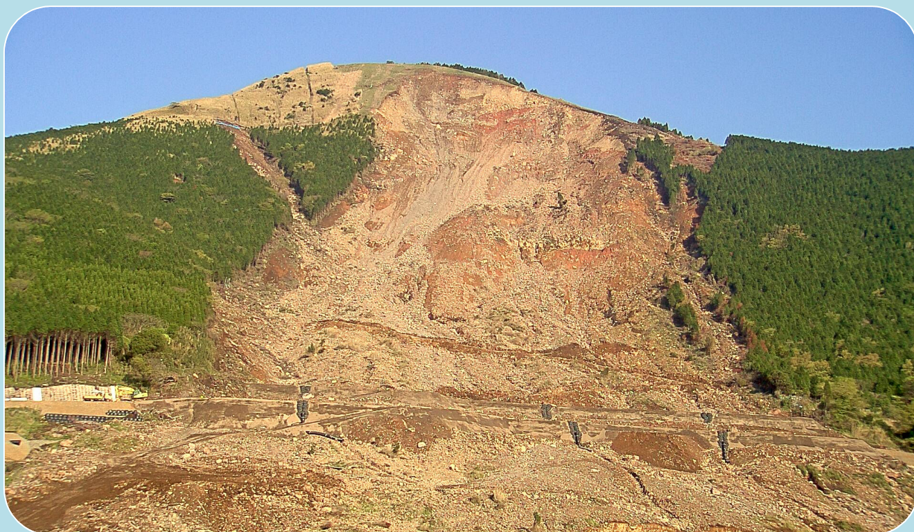
阿蘇大橋地区斜面崩壊対策の進捗状況 (平成29年4月28日撮影)
