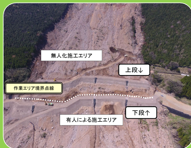
土留盛土工（ドローンによる撮影）
