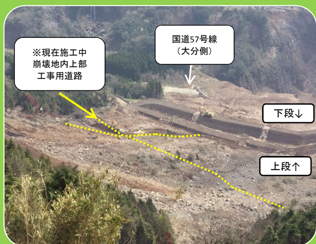
土留盛土工（山頂より撮影）
