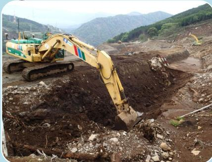
順調なペースで土砂を掘削しています。6月の梅雨入り前までに上段捕捉部に堆積した土砂を撤去する必要があります。
