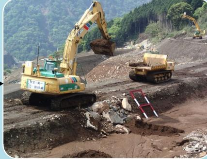
掘った(掘削した)土砂を不整地運搬車へ積み込みを行っています。捕捉部中央に紅白色で塗装されているのは、計測用の定規です。写真上だと小さく見えますが高さが4mあります。降雨で流されて堆積した土砂が、どこまで積もったかを測る目的で設置しています。
