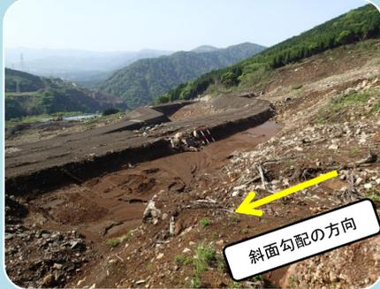
降雨等により土留盛土工上段部の捕捉部(ポケット)に堆積した土砂を重機を使用して撤去します！※無人化施工で工事を行います。
