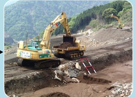
重機(バックホー)にて積み込んだ土砂を仮置き場へ運びます。工用道路のため、道が凸凹したり、上り下りがあったりします。一般車両では走行できない場所では不整地運搬車が活躍します！
