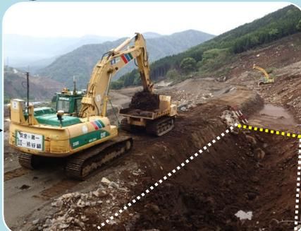
写真右側の黄色点線より手前側が掘削が完了した箇所です。堆積した土砂の量を断面的に見ることができます！
