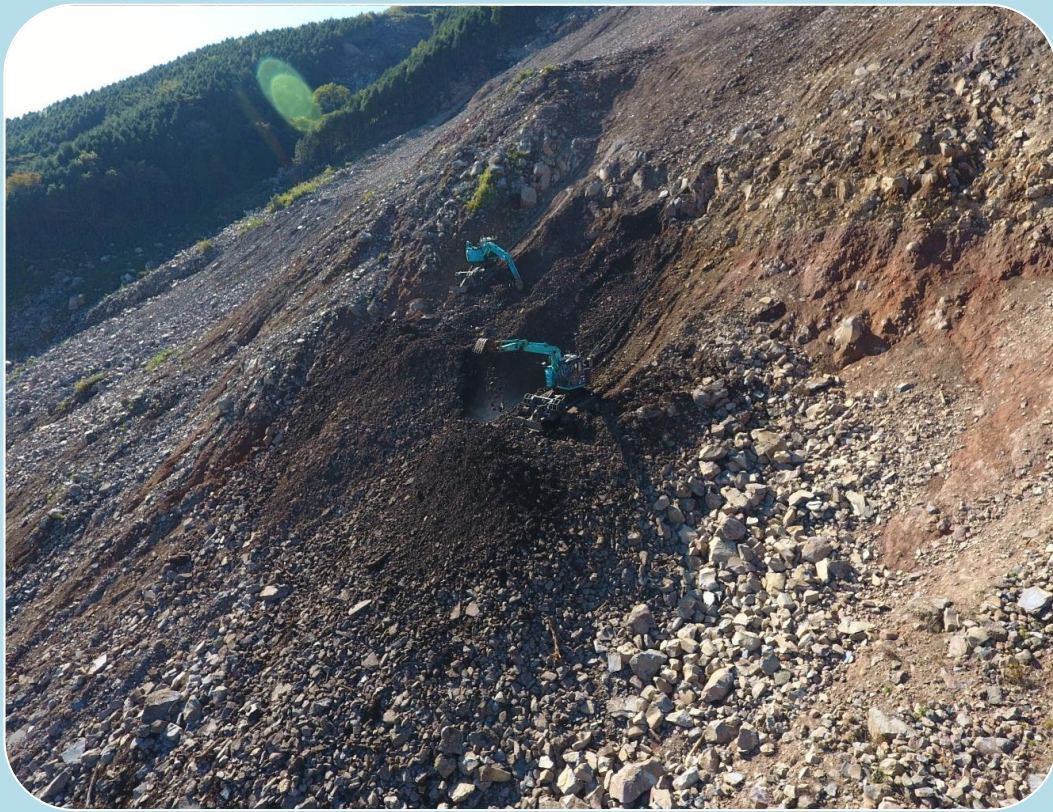
阿蘇大橋地区斜面防災対策の進捗状況（平成29年10月ドローンによる撮影）
