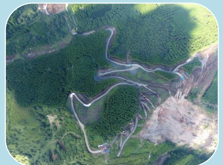
頭部工事用道路
