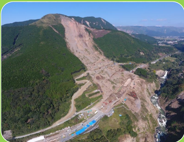
全景写真（ドローンによる撮影）
